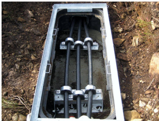
vzor rozdělení kabelů v přístupové komoře
